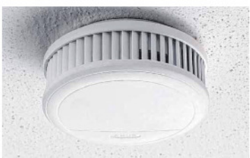
Vorgeschrieben ist laut Gesetz mindestens ein Rauchmelder in jedem Kinderzimmer, in jedem Schlafzimmer und in jedem Flur, der mit Aufenthaltsräumen verbunden ist.
